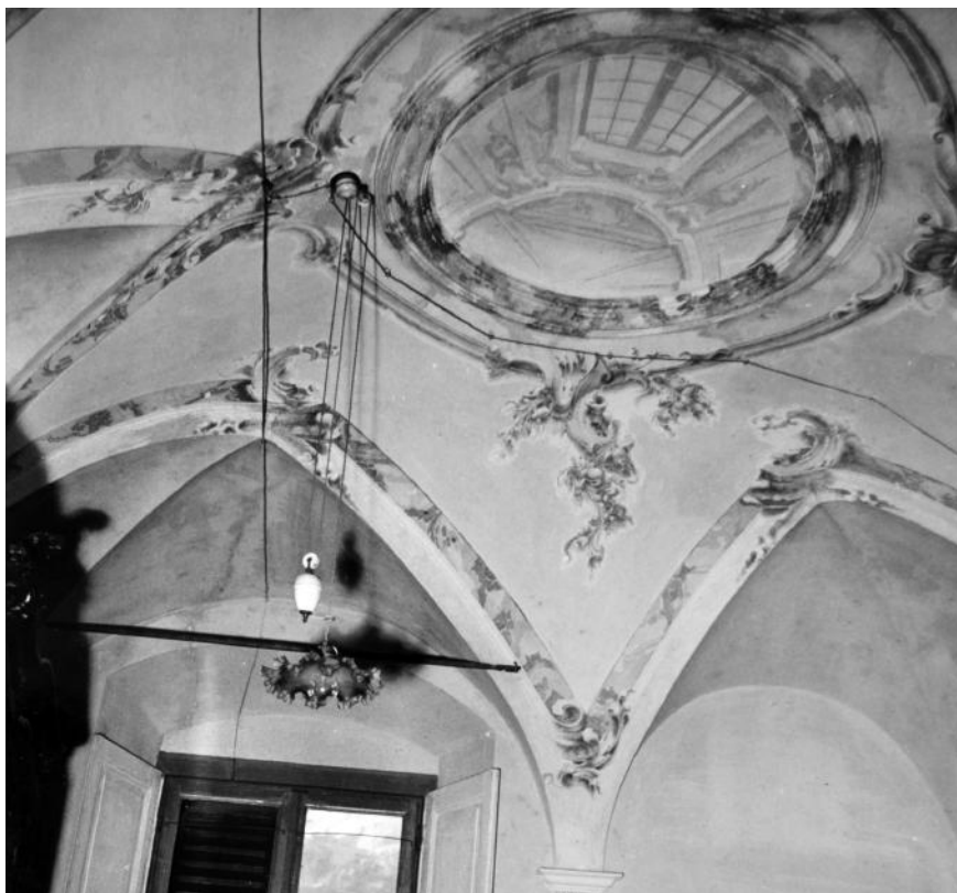
Particolare del soffitto di Palazzo De Simoni
